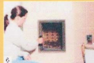
6 Keď sú nad pahrebu len malé plamienky, môžete uzavrieť — t.zn. zatvoriť prívod vzduchu pre horenie. Prikladacie dvierka opätovne otvorte až po 12 hodinách.
