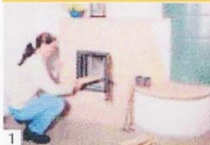
1 Drevo v ohnisku ukladajte do prekřížených vrstiev a otvorte prívod vzduchu pre horenie.
